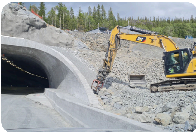
Tunnelportal ved E16 Kvamskleiva
