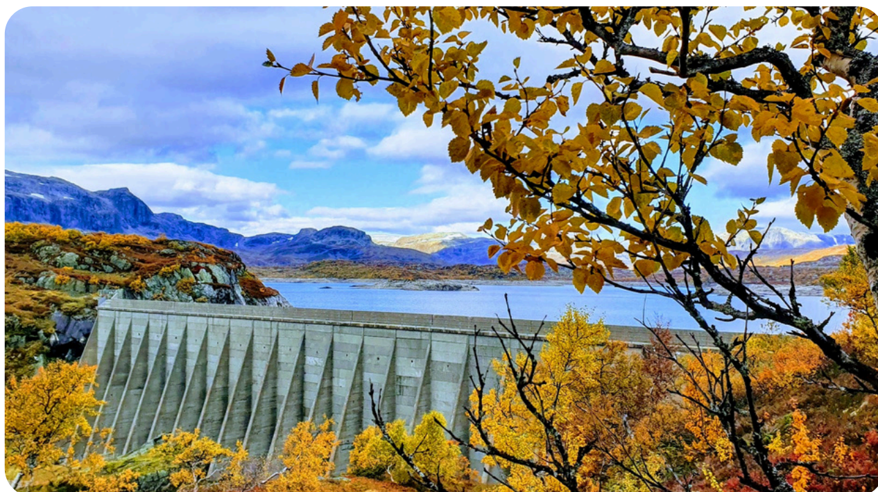
Kjela dammer - eksempel på et rehabiliteringsprosjekt for fornybar kraftproduksjon
