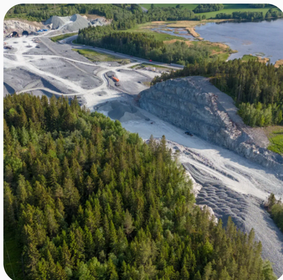
E6 Kvithamar - Åsen under bygging
