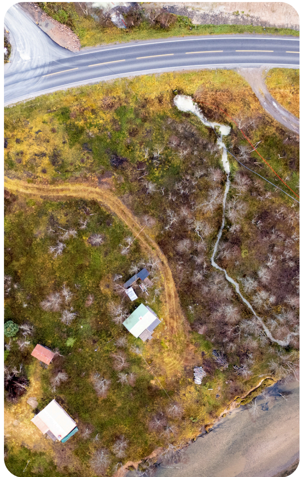
Slambasseng med logging av vannkvalitet ved Kanstadbotn på E10 Hålogalandsvegen
