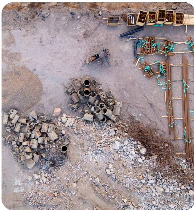
Overskuddsmateriell på E10 Hålogalandsvegen
