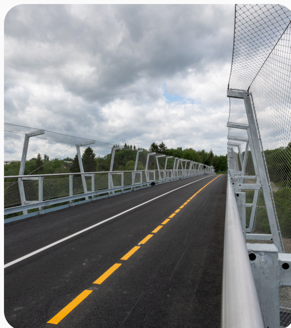
Ferdigstilling av Saupstadbrua, Contur
