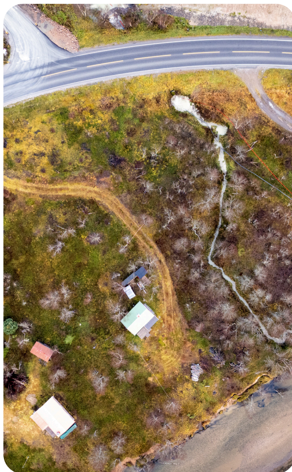
Slambasseng med logging av vannkvalitet ved Kanstadbotn på E10 Hålogalandsvegen.
