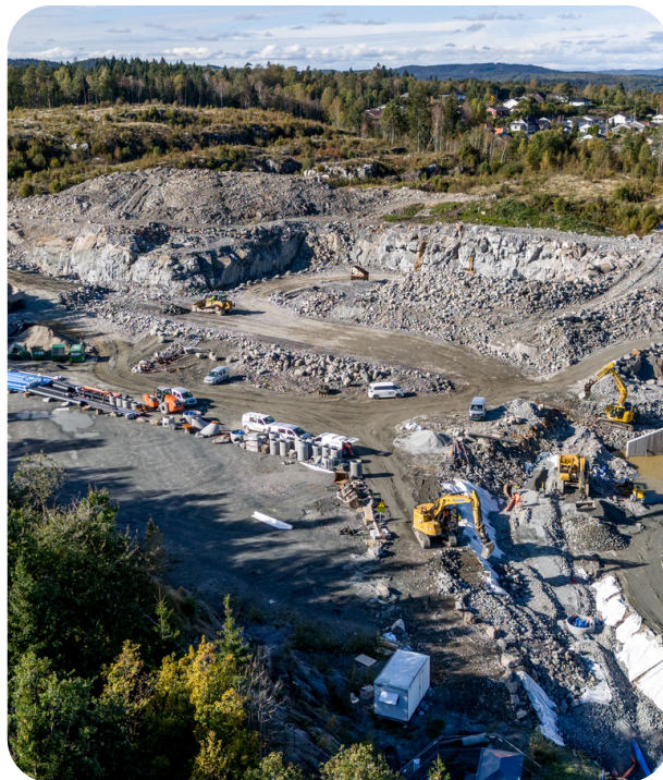
Alle konstruksjonene bygges med lavkarbon klasse A/B? på Fv. 353 Rugtvedt-Surtebogen (Gassveien). Foto: Tor Kleiven
