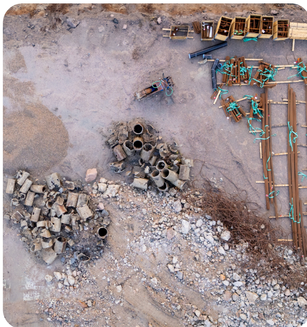
Materialer til ombruk på E10 Hålogalandsvegen
