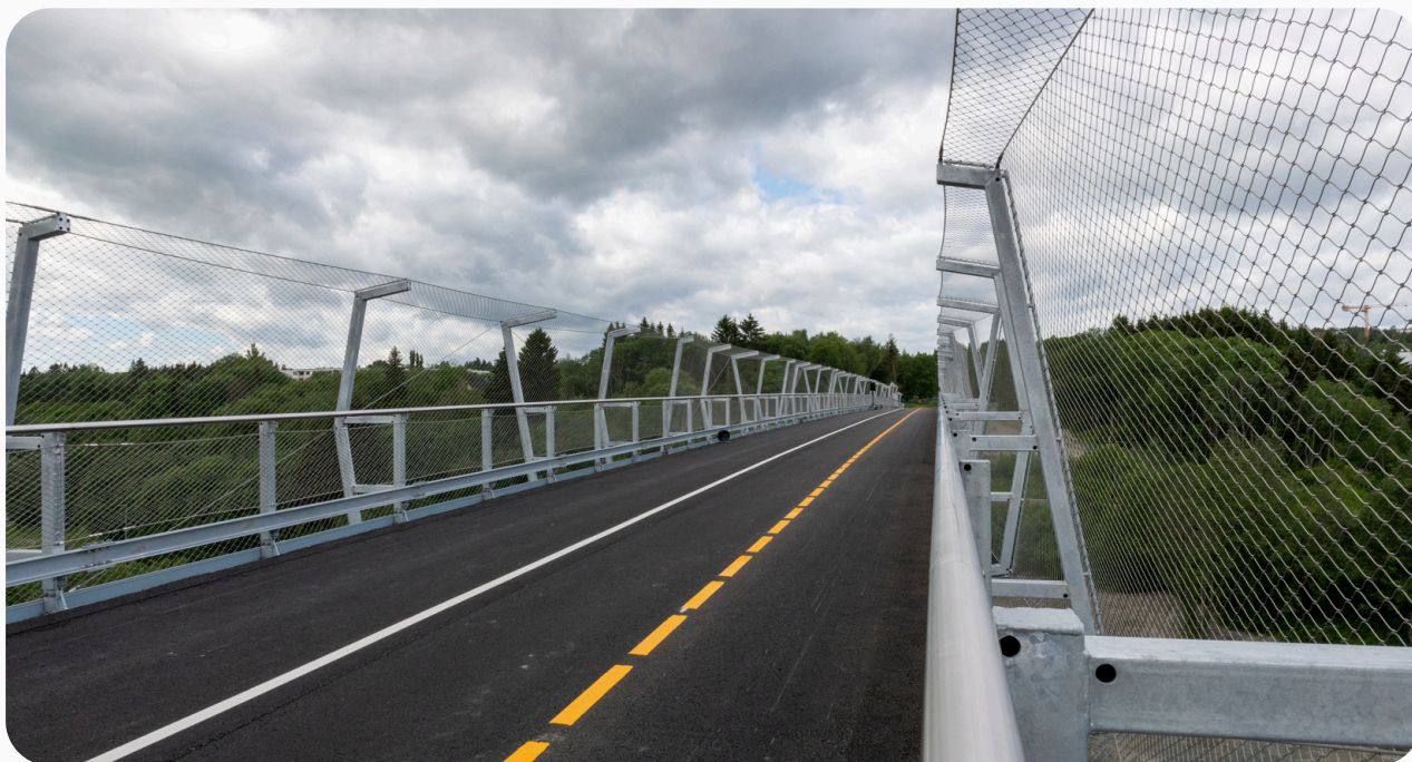
Ferdigstillelse av Saupstadbrua, Contur
